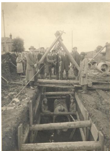
Рис. 2. Строительство канализационной сети в Перми.
