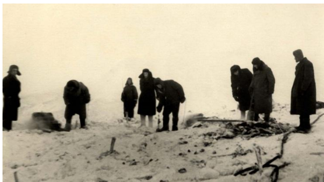
Рис. 9. Заряжение скважин оксиликвитом на руднике «Гора Рудная». 1944 г.
